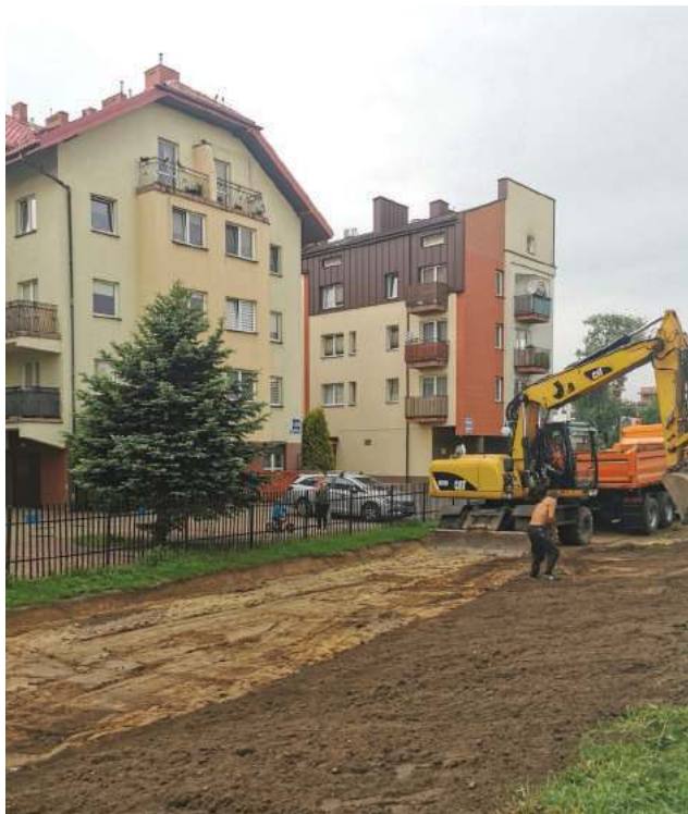
Wyboistą drogę zastąpi utwardzona ulica
