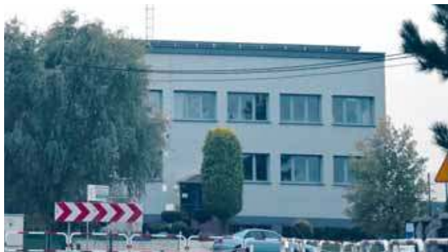
Ptaki upodobały sobie panele fotowoltaiczne na dachu szkoły podstawowej w Tąpkowicach, zmniejszając wydajność urządzeń
