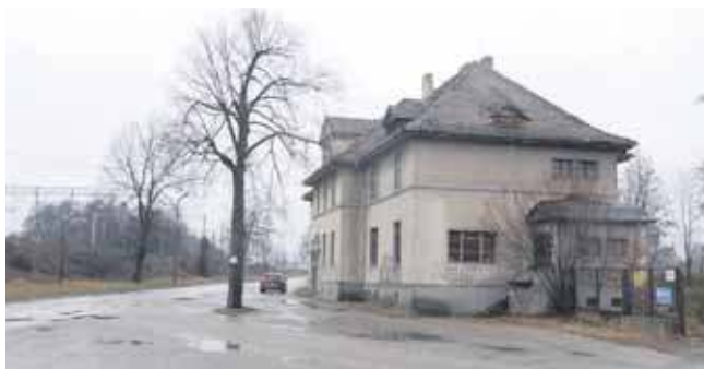
Ślad drogi został poprowadzony w miejscu, gdzie teraz jest budynek dawnego ambulatorium Kaletańskich Zakładów Celulozowo-Papierniczych. Trzeba by go więc wyburzyć, ale to własność prywatna, na dodatek wpisana do gminnej ewidencji zabytków
