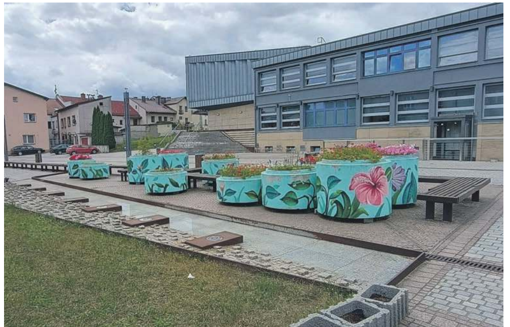
Fontanna została wyłączona z użytkowania, bo pod spodem pojawiły się nieszczelności
