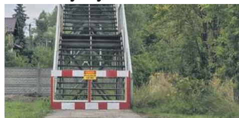
Przejścia nad torami nie ma
