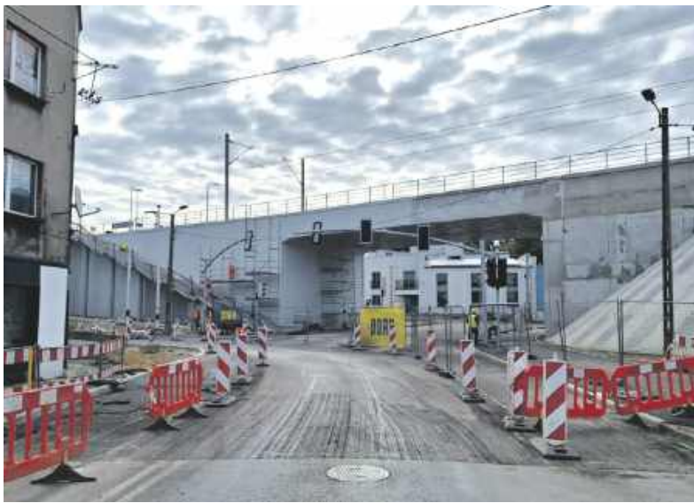
W ostatnich dniach sierpnia prace wyraźnie przyspieszyły
