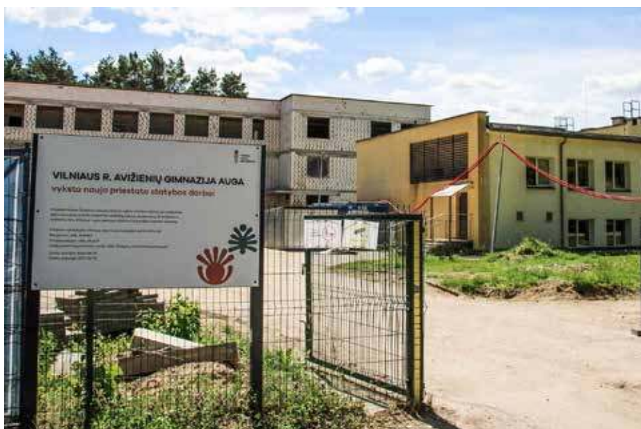
Szkoła czeka na nową dobudówkę, która jest w trakcie budowy
