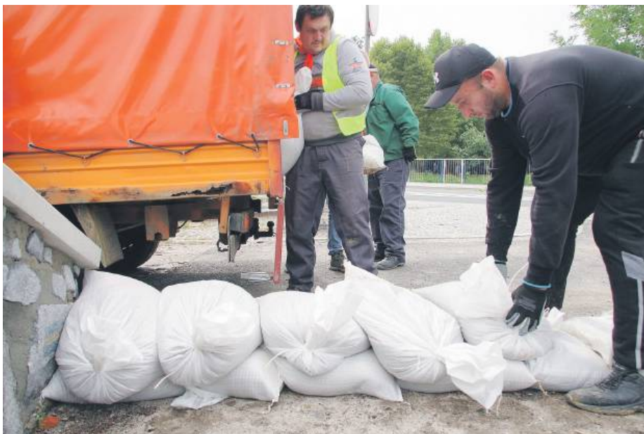
Pracownicy CUKiT układający wał zabezpieczający przed zalaniem nowo oddanego skateparku przy ul. Wojska Polskiego
