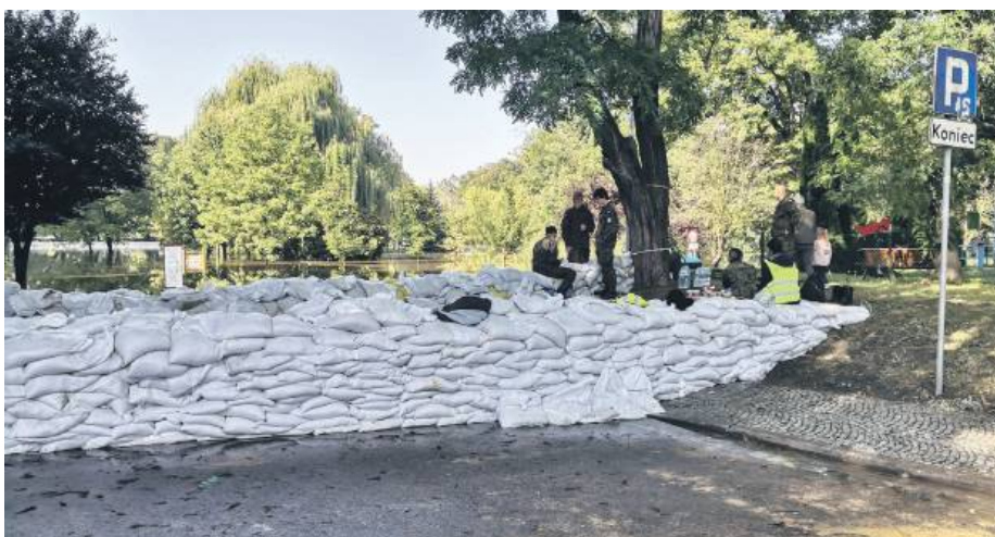
Ogromna barykada kilkuset worków ułożona została na granicy parku miejskiego im. Armii Krajowej i ul. Okrzei. Bariera nie przepuściła wody
