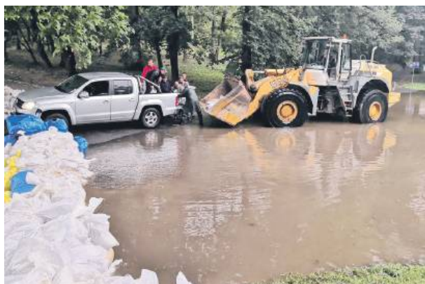
Przy budowie wału w parku miejskim wykorzystywany był ciężki sprzęt
