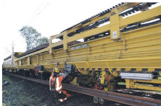
PUN to 300-metrowa maszyna, która podnosi tor i wymienia podkłady. Przez kilka dni urządzenie wymieni pięć tysięcy podkładów
