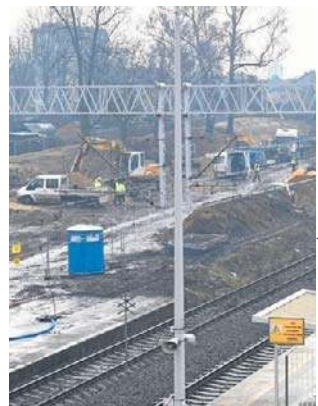
Przy stacji rozpoczęła się budowa parkingu
