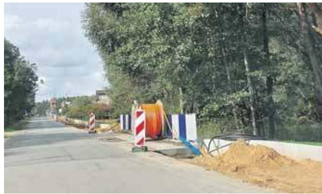
Pojawiły się problemy z przebudową prowadzącej nad stawy w Zielonej ul. Ofiar Katyń w Kaletach
