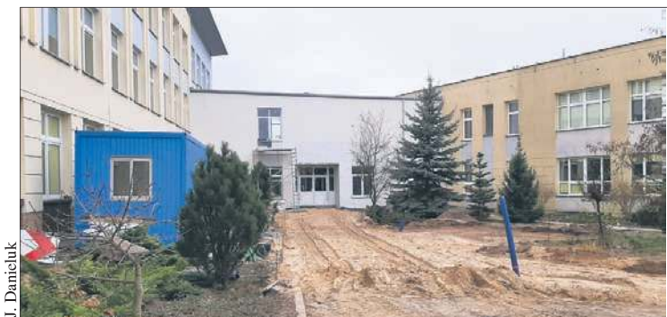
Trwa budowa nowego łącznika w Szkole Podstawowej nr 22
