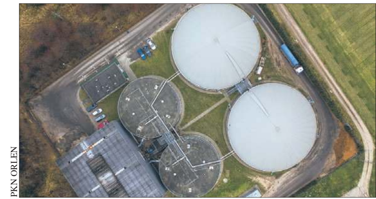
Biogazownia w Konopnicy, gm. Rawa Mazowiecka
