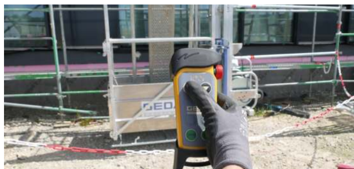
Fot. 2. Sterowanie pilotem radiowym dźwigu GEDA 200 Z COMFORT
