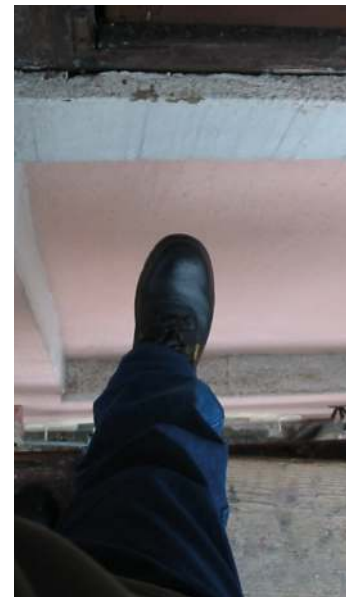
Rys. 2. Brak zabezpieczenia balustradami przy wstępie do obiektu [12]
