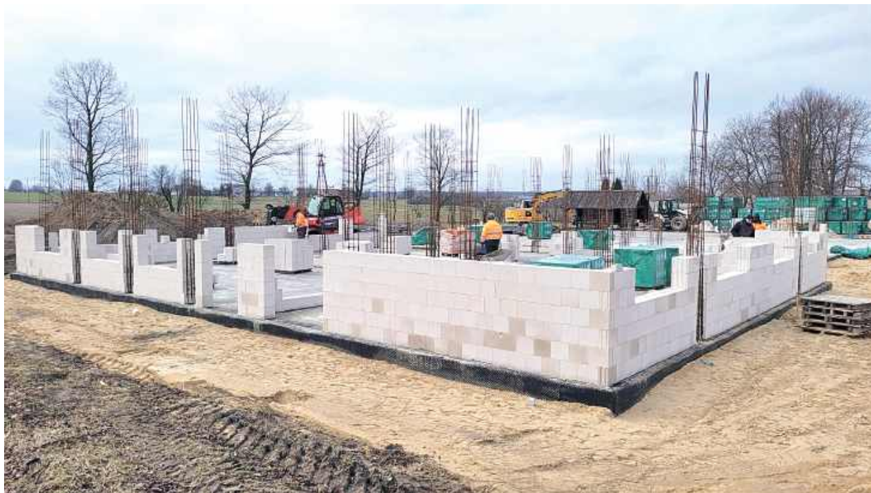
Pod koniec stycznia br. prace związane z budową rozpoczął wykonawca. Okres realizacji inwestycji wynosi dziewięć miesięcy
