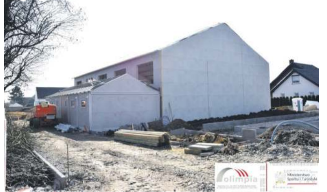
Budowa Olimpii w Szewcach
