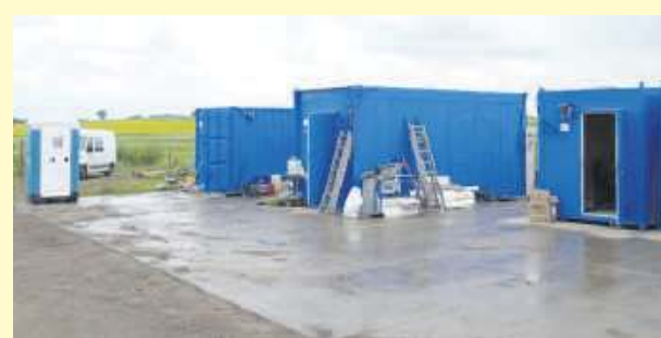
W ubiegłym tygodniu ruszył ostatni etap remontu zbiornika zalewowego w Przewornie. Ustawione zostało już zaplecze socjalne
