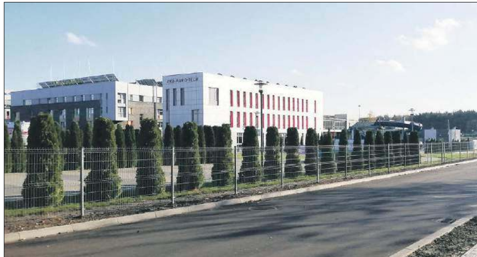
Przy budynkach uczelni właśnie powstaje droga do stacji kolejowej. Umożliwi ona dojazd do działki za istniejącą już infrastrukturą uczelni, na której powstanie nowy akademik z częścią dydaktyczną
