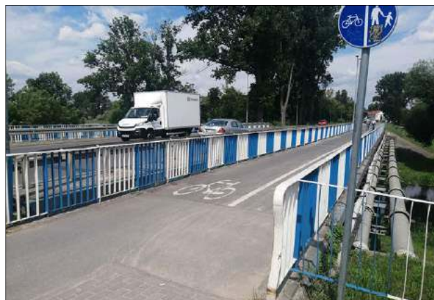
Miasto nie powtórzy na razie unieważnionego przetargu. Na drodze do modernizacji stanęły barierki
