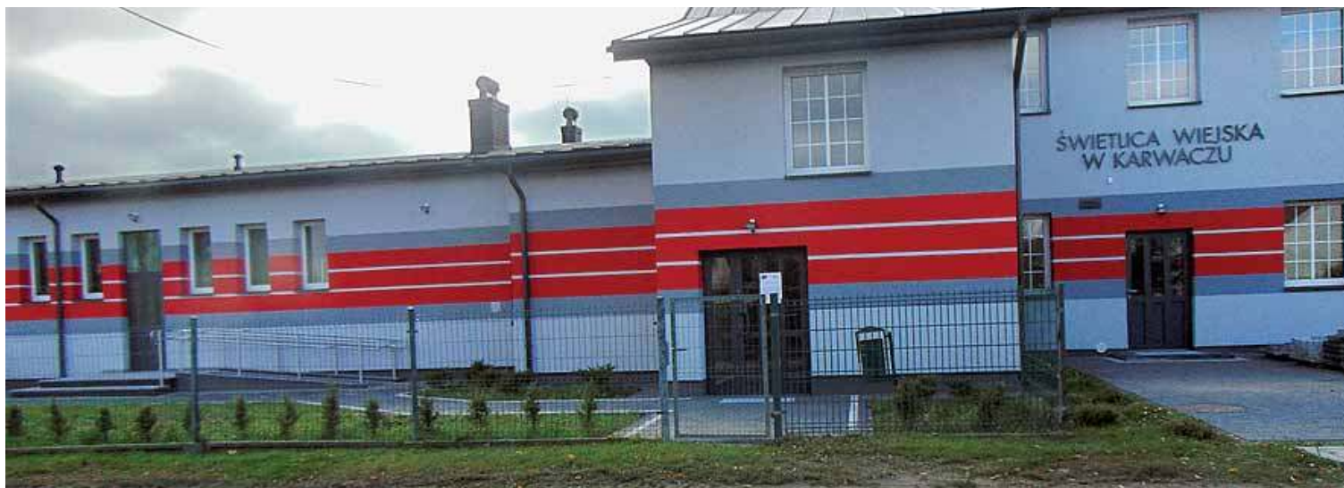
Przebudowa świetlicy gminnej w Karwaczu
