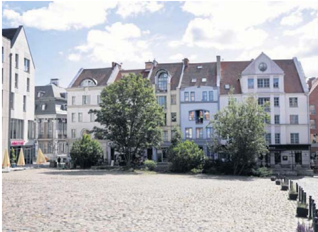
8 ekspozytorów zostanie ustawionych w miejscach dawnych filarów oddzielających nawy kościoła
