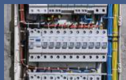
Montaż i zabudowa rozdzielnic modułowej
