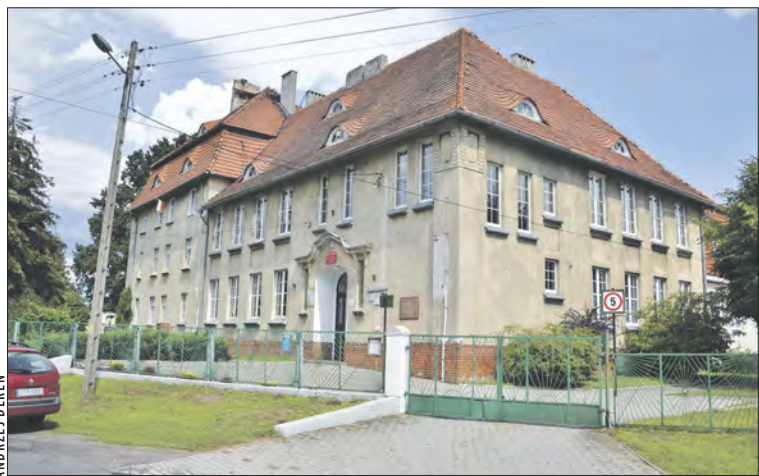
Spółeczność wiejska chce przejąć opiekę nad gminną szkołą. W wielu miejscowościach gdzie samorządy likwidowały lub redukowały placówki oświatowe, chwalą sobie takie rozwiązanie.
