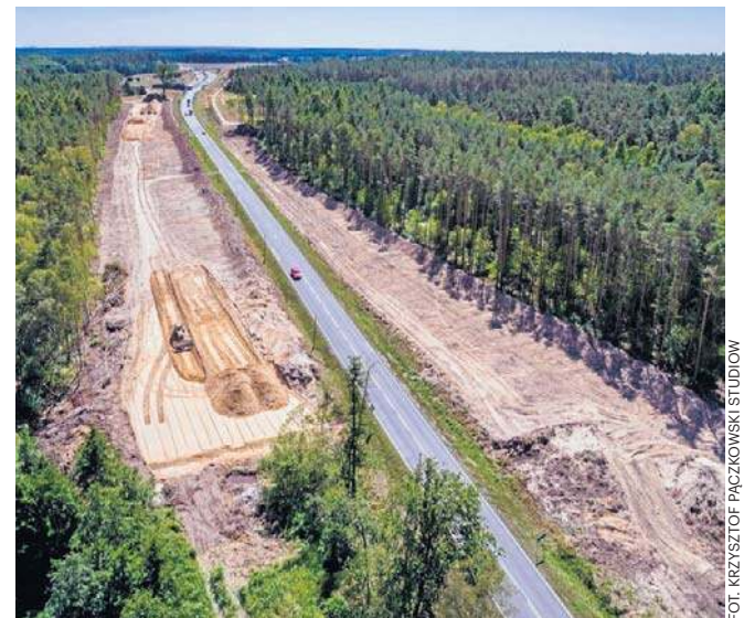
Postęp prac przy budowie drogi ekspresowej S11.
