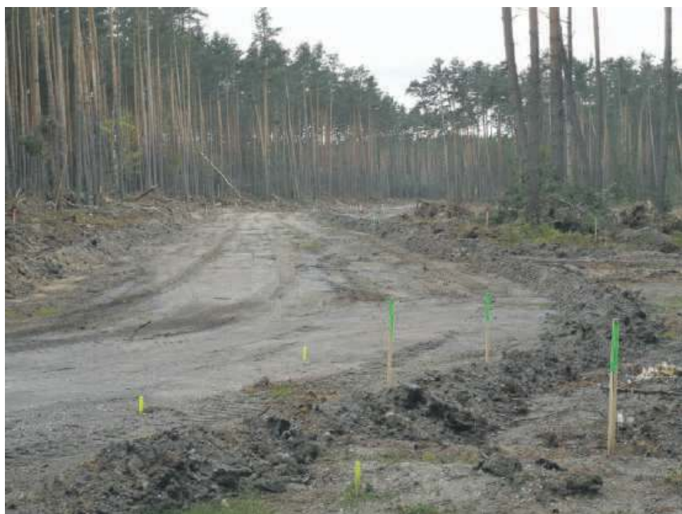
Pierwsza część nowej drogi przeciwpożarowej, która powstaje w podolańskich lasach, będzie miała ok. 3 km
