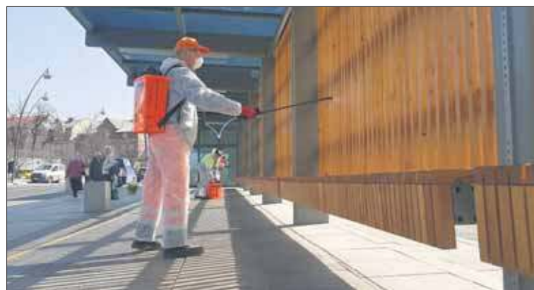
Przystanki są dezynfekowane za pomocą wody ozonowanej
