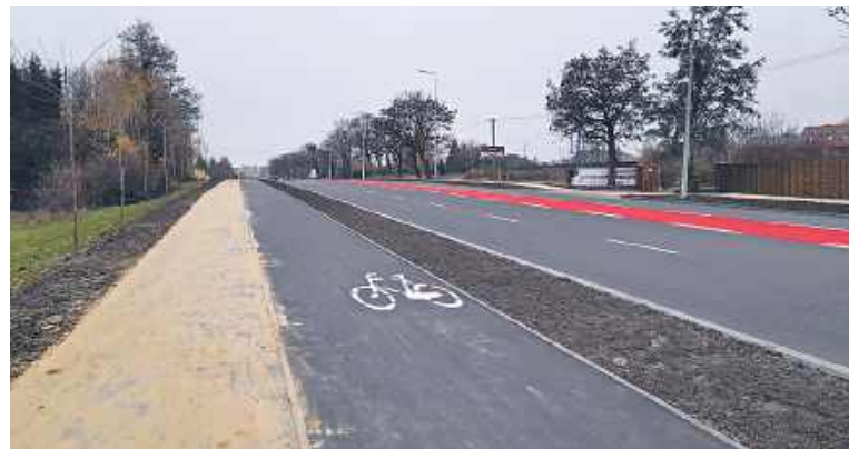
W ramach projektu wykonawca już przebudował ul. Zawadówkę i właśnie kończy przebudowę ulicy Włodawskiej (na zdjęciu), gdzie pozostały do wykonania kosmetyczne prace
