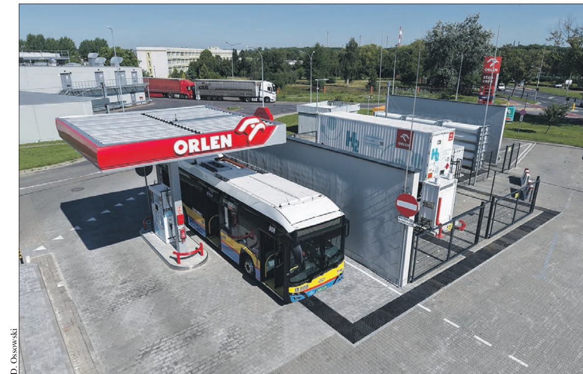
Stacja paliwa wodorowego przy ul. Łukasiewicza
