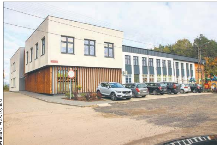
Tak prezentuje się budynek szkoły po modernizacji
