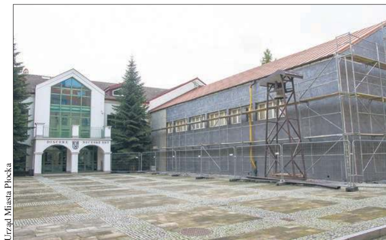
Trwa termomodernizacja sali gimnastycznej w Małachowiance
