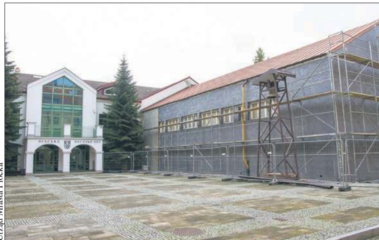
Trwa termomodernizacja sali gimnastycznej w Małachowiance
