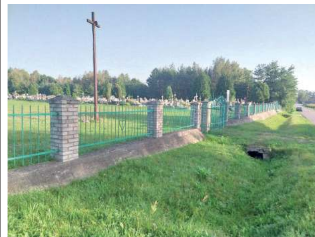
Ogrodzenie na cmentarzu w Lipinach Górnych-Borowina, przedzie gruntowny remont
