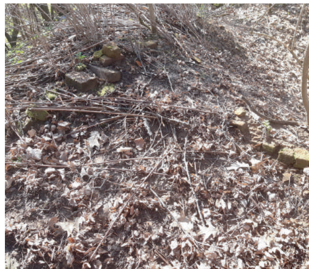
Pozostałości po murze pieca dawnej gorajskiej cegielni
