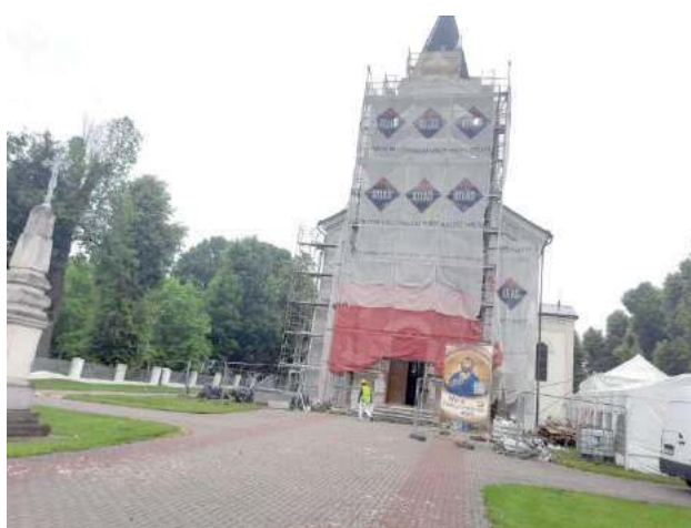
W Łukowej remontowana będzie wieża dzwonnicy. Prace czekają też przy ogrodzeniu na zabytkowym cmentarzu przykościelnym
