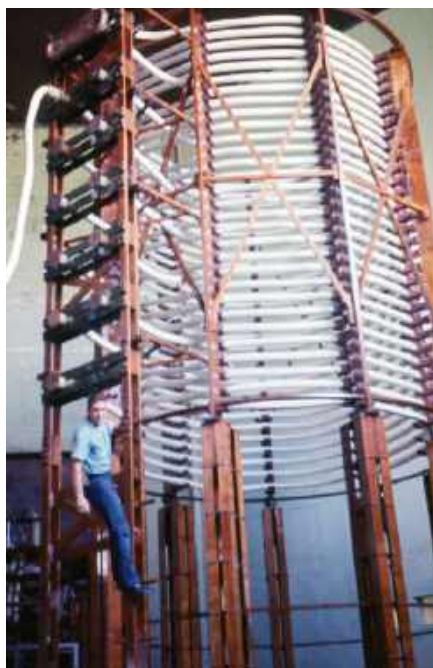
Rysunki 1...3. Przykłady wariometrów RF z lat 60. (zmienne cewki) i cewek RF w „spiralnym domu” jako część końcowego zasilania anteny VLF US Navy do komunikacji podwodnej. Znajdują się one w US Naval Communications Station w Balboa w Panamie i zostały wyprodukowane przez Continental Electronics. Źródło: www.navy-radio.com/xmtr-vlf.htm
