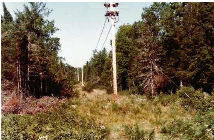
Rysunek 13. Część 23-kilometrowego ramienia anteny ELF w lesie nad jeziorem Clam Lake w stanie Wisconsin. Źródło: www.navy-radio.com/commsta-elf.htm
