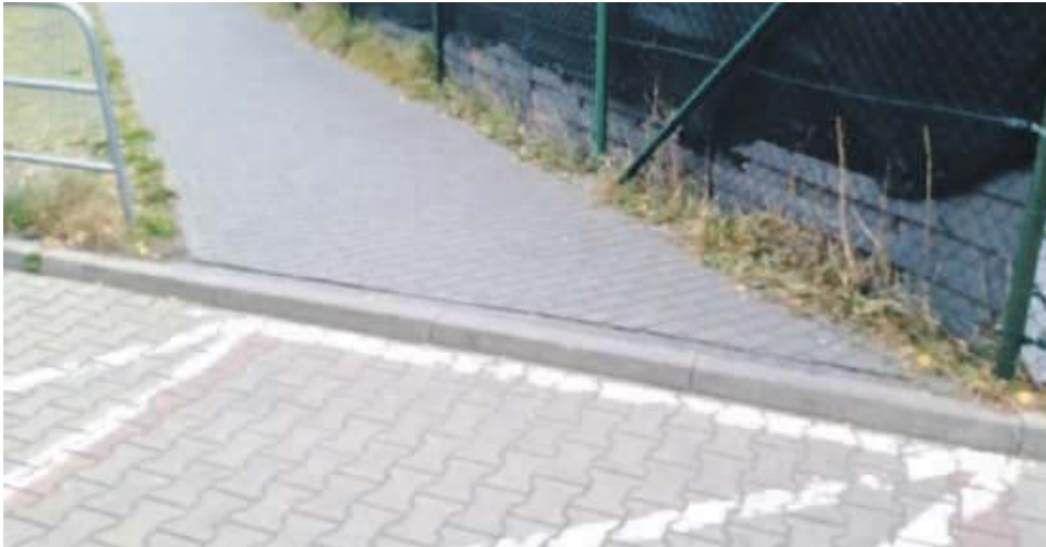
Krawężnik przed obniżeniem
