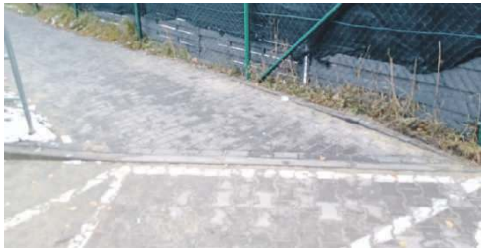
Krawężnik po obniżeniu
