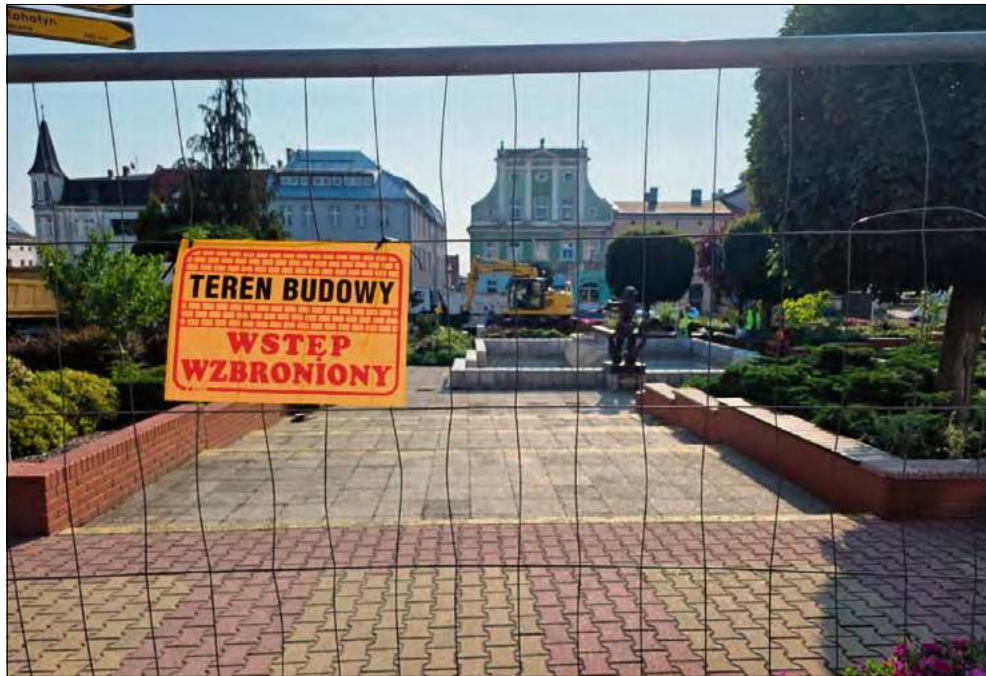
Plac budowy został ogrodzony, a wykonawca rozpoczął pierwsze prace rozbiórkowe.
