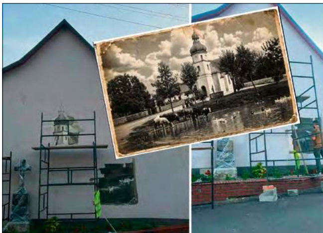
Rozpoczęły się prace nad murem, który powstaje na pamiątkę zakończenia renowacji kaplicy w Oleszce oraz obchodów 150-lecia jej budowy.
