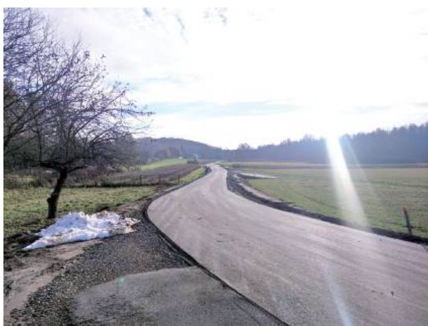
Nowy asfalt na Słowiczej już gotowy
