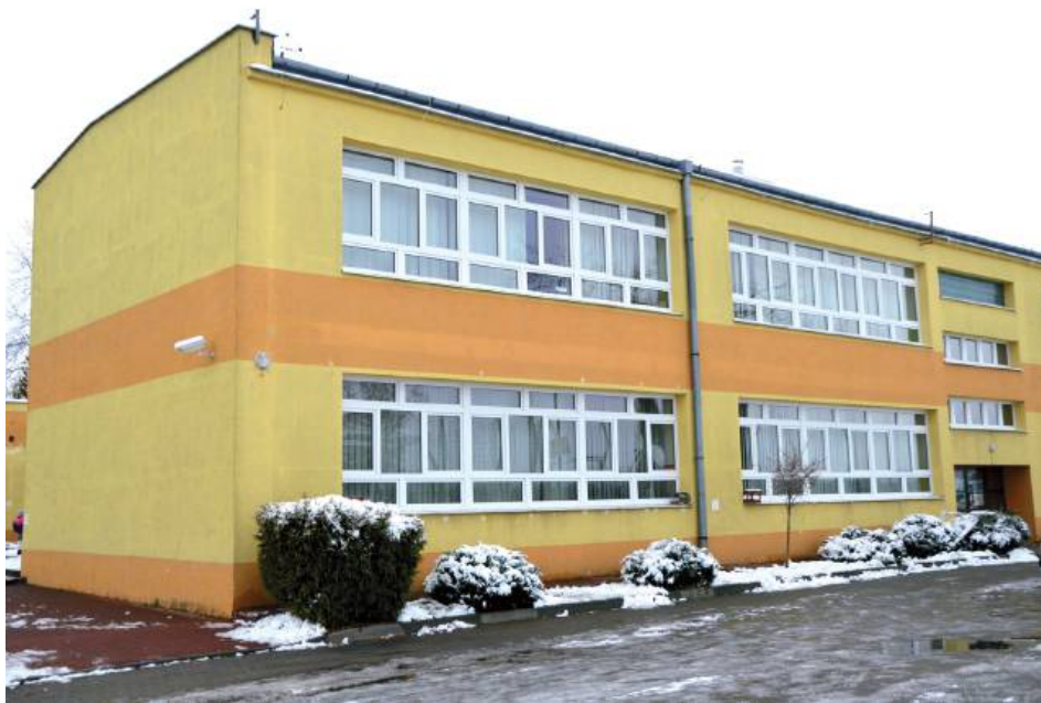
Tak obecnie prezentuje się stara część SP im. Adama Mickiewicza w Żyrzynie. W przyszłym roku budynek czeka spora zmiana - ma przejść termomodernizację
