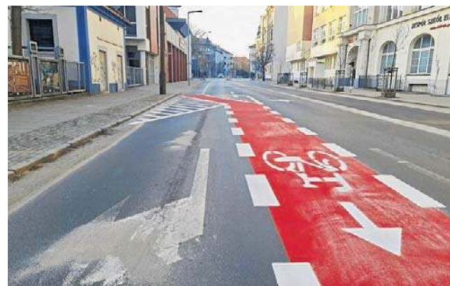
Śluza rowerowa na ul. Dąbrowskiego została wymalowana pomiędzy dwoma pasami jezdni
