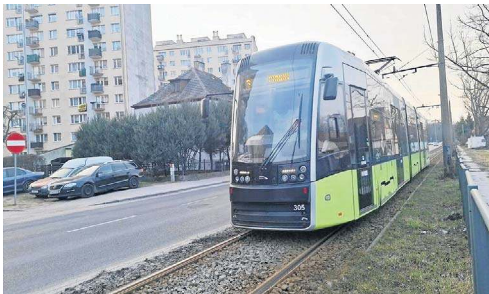
Jednotorowy odcinek wzdłuż ul. Pomorskiej ma około 350 metrów
