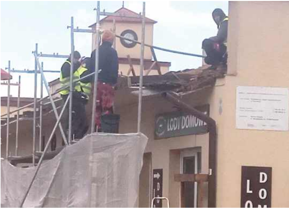
GR Pierwsze prace ruszyły przed Wielkanocą
