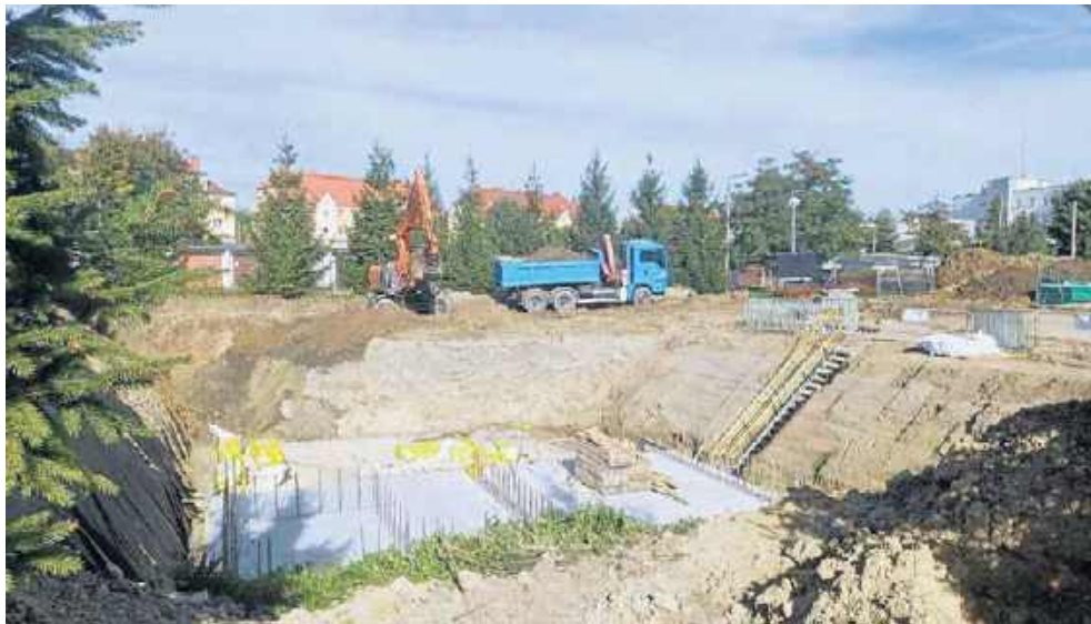
Jeden z dwóch malborskich schronów powstaje na terenie KP PSP
