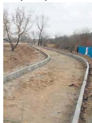
Nad Pilicą powstaje dalsza część ścieżki rowerowej.
