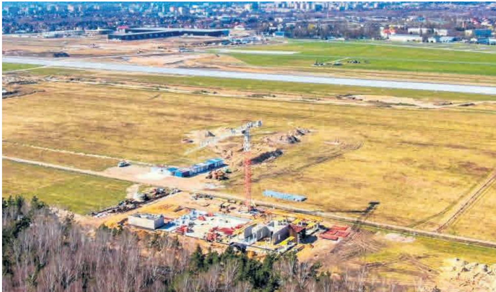
W sprawnym tempie kontynuowana jest budowa wieży kontroli lotów i lotniskowej straży.
