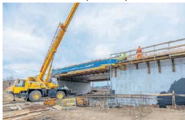
Na wszystkich radomskich odcinkach trasy kolejowej numer 8 trwają obecnie intensywne prace budowlane.
