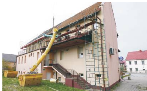
W minionym tygodniu pracownicy firmy Skomar z Kamieńca Żąbkowickiego rozpoczęli remont dachu na Ośrodku Zdrowia w Przewornie
