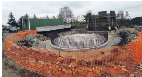
Obecnie w Starym Wiązowie trwają prace przy konstrukcji reaktorów SBR. Fot. NDI
