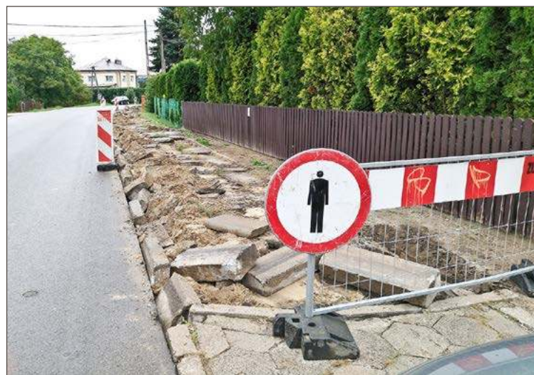
Stare płytki na chodniku przy Świętosława zastąpi kostka brukowa.
