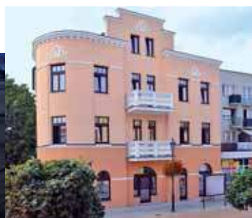
Kamienica przy ul. Warszawskiej 18 po renowacji
