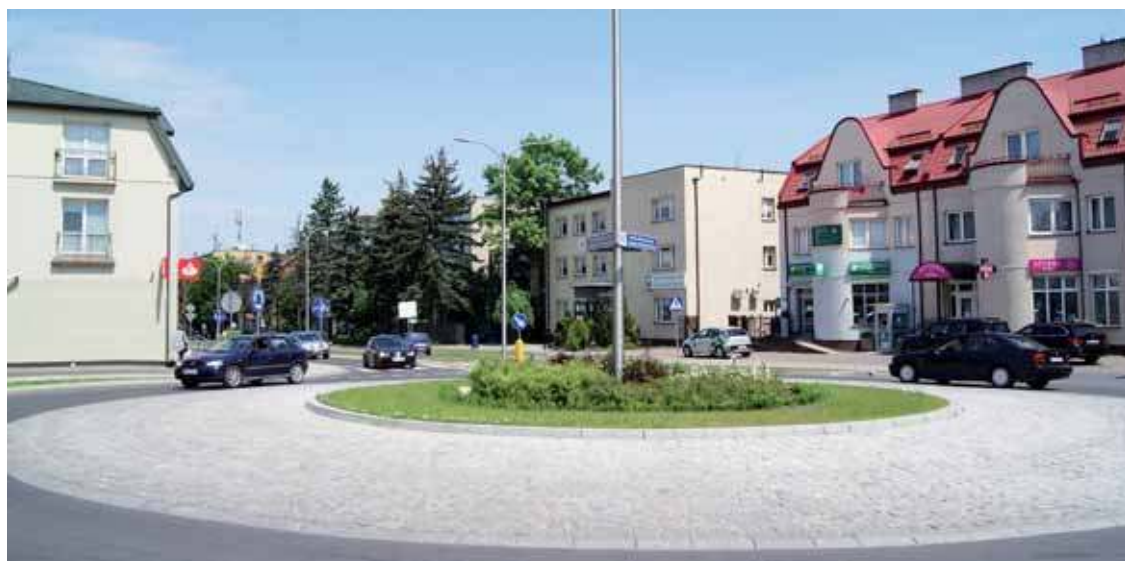
Jedna z ostatnich inwestycji samorządu powiatowego. Nowo zbudowane rondo przy siedzibie Komendy Powiatowej Policji w Mławie
