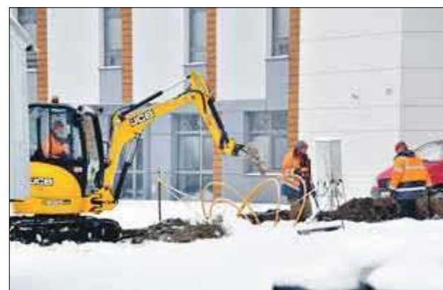
Trwa budowa kolejnego etapu: szkoły przysposabiającej do pracy i środowiskowego domu samopomocy oraz mieszkań treningowych z możliwością przekształcenia na dom pobytu stałego dla dorosłych osób z autyzmem
