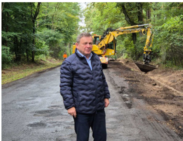
Starosta Jan Janas na remontowanym odcinku drogi powiatowej Wołów - Garwól - Gródek.
