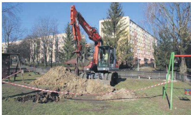
Wykop na placu zabaw w okolicy ul. Kilińskiego. Tak roboty wyglądały w niedzielę.
