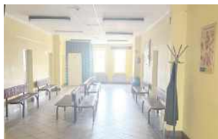
Korytarz przed remontem
