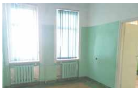
Sala chorych przed remontem
