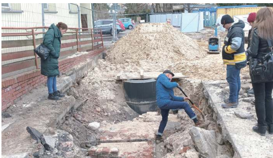
Prace przy rozbudowie szpitala w Opolu Lubelskim prowadzone są pod nadzorem archeologicznym, a kieruje nim Edmund Mitrus z Pracowni Badań i Nadzorów Archeologicznych z Lublina
