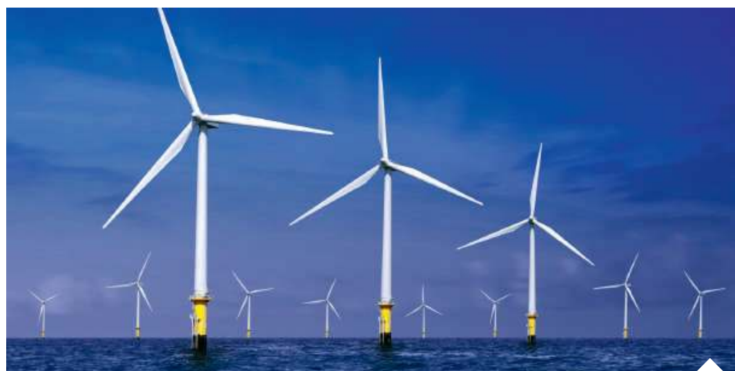
Dzięki OZE Polska do 2050 r. jest w stanie obniżyć poziom emisji CO 2 aż o 91 proc. | fot. AdobeStock/d
