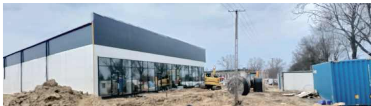
Prace przy budowie nowej galerii postępują z tygodnia na tydzień
