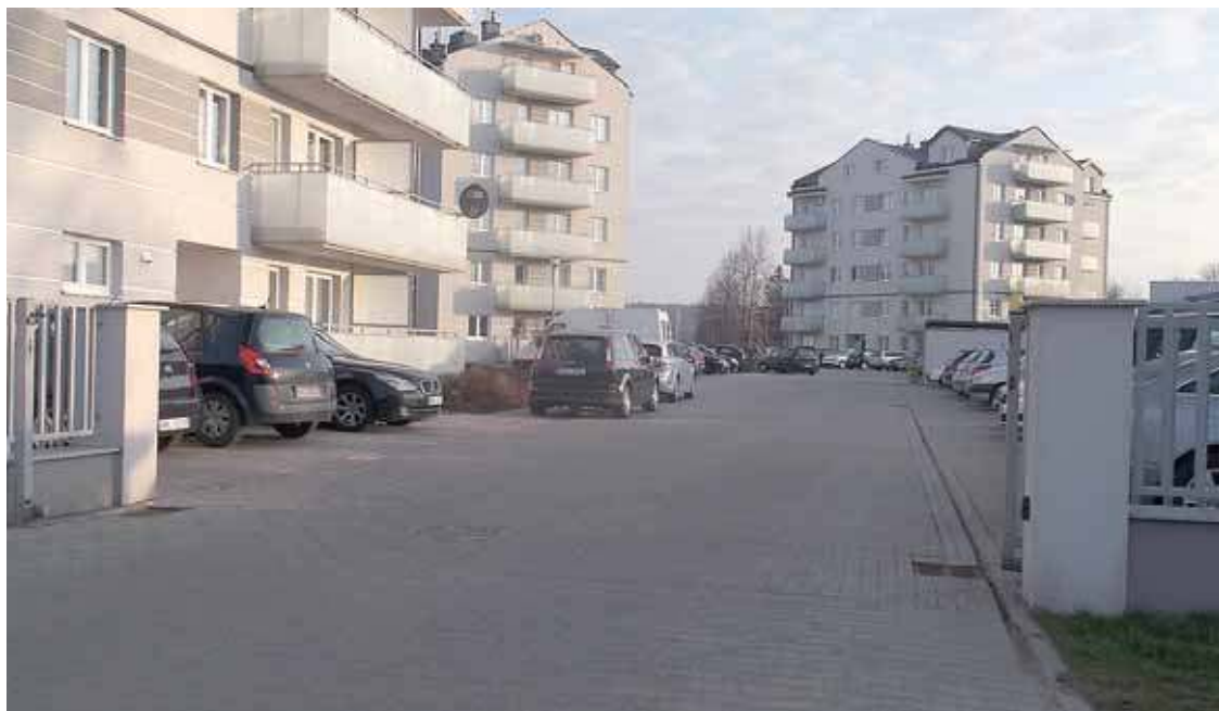
Nowo zbudowane osiedle przy ul. Antoniego Torfa-Załęskiego w Mławie
