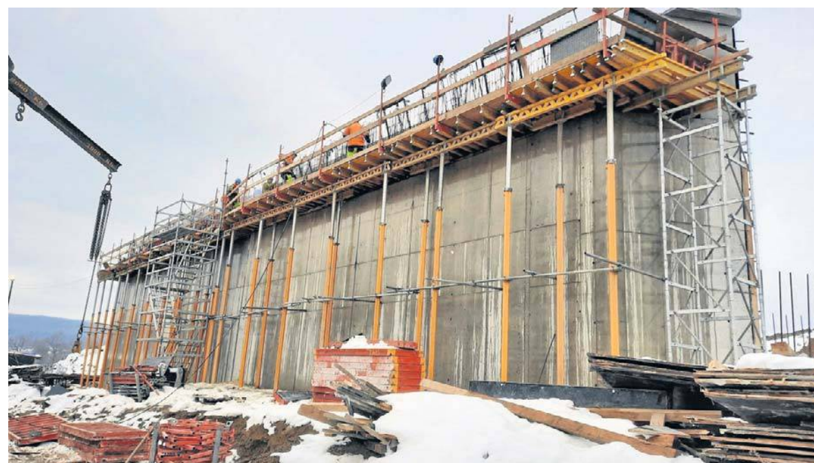
Choć zima, to na budowie S19 Rzeszów Półd. - Babica trwają roboty. W zakresie, w jakim pozwala technologia
