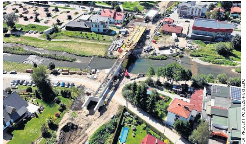
Mszana Dolna. Jednym z nowych obiektów będzie most kolejowy. Jego przęsło jest już nad Mszanką
