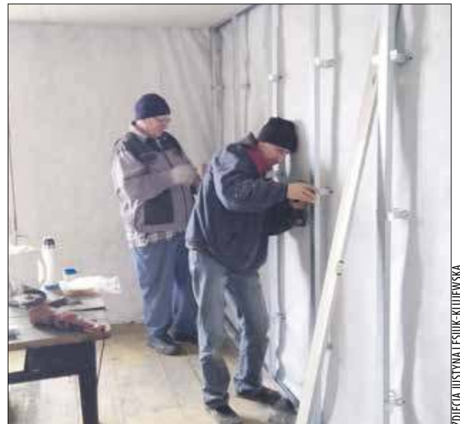
Panowie z urzędu gminy samodzielnie sprzątnęli dom po pożarze i wykonują prace remontowe
