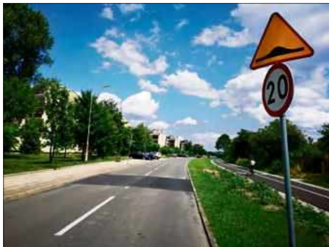
Po progu zostały znaki, ale dziury po śrubach zostały zalane asfaltem.
