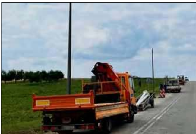
Robotnicy już stawiają nowe maszty.
