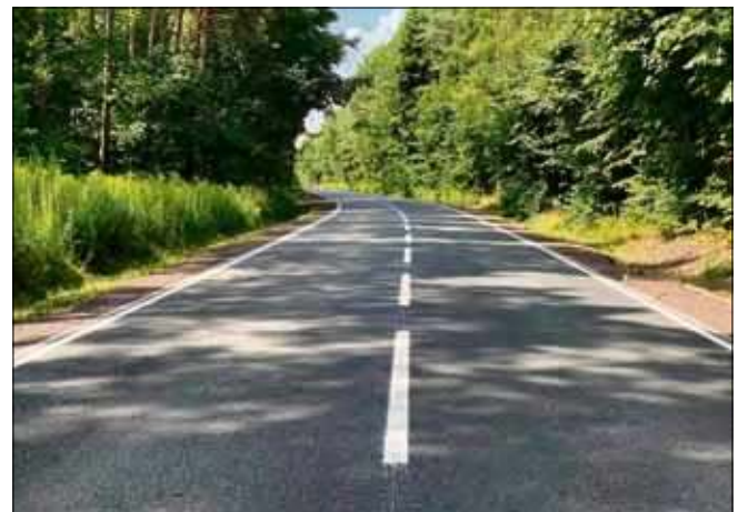
Przebudowa drogi pomiędzy Chorulą a Góraždami kosztował powiat 2 mln zł.
