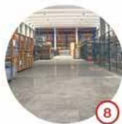
Posadzki przemysłowe betonowe
