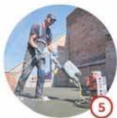
Wylewki maszynowe, styrobeton
