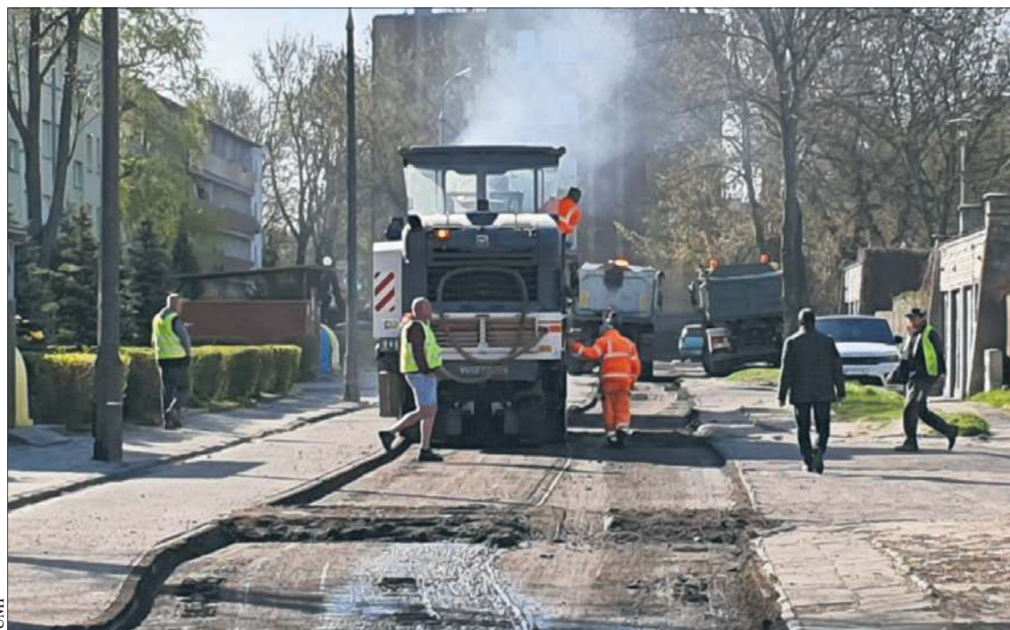
UMP Rozpoczęła się przebudowa pierwszej części ulicy Kredytowej
